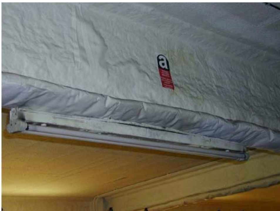
Figura 4.11 Izolant din azbest pe o structură metalică.
