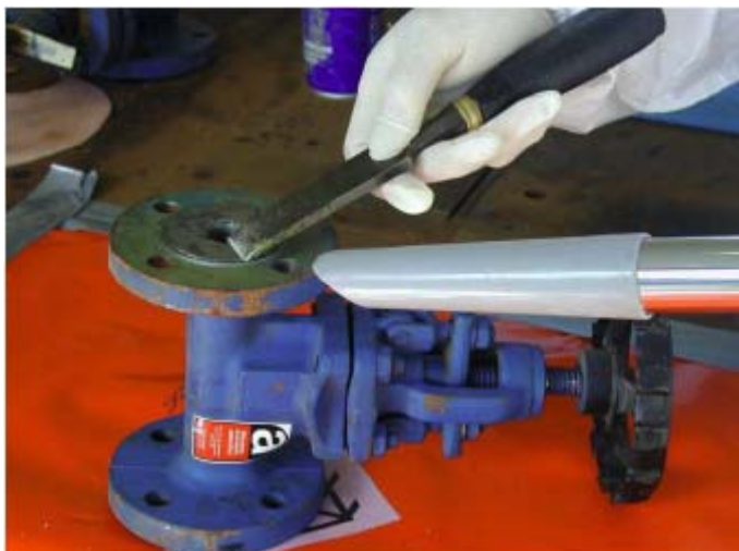
Figura 11.6. Utilizarea unui aspirator pentru strângerea prafului degajat în timpul curățării joantelor și garniturilor din azbest la o vană.
