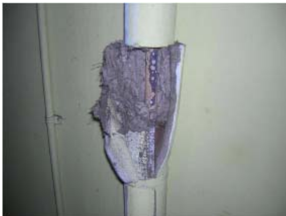
Figura 12.7. Izolant de țevă din azbest prezentând mai multe straturi și pătrunderea agentului de umectare.
