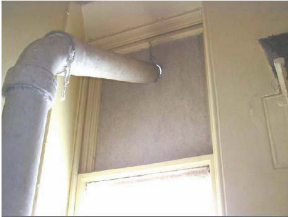
Figura 4.5 Țeavă de gaz de combustie din azbociment cu frânghie împletită din azbest care traversează panoul de izolare din azbest.
