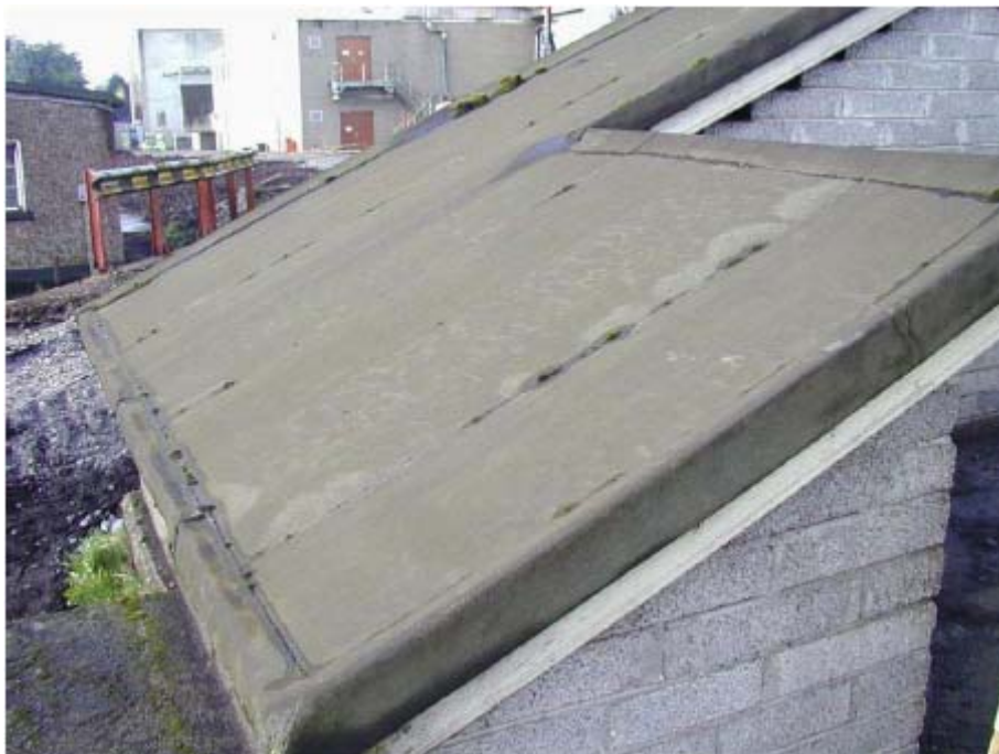
Figura 4.7 Pâslă bitumată cu acoperire azbestată (roofing amianté)
