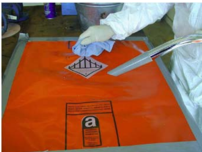
Figura 11.7. Curățarea cu grijă a zonei de lucru cu un aspirator tip H și cârpe ude.
