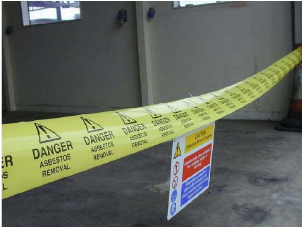
Figura 11.1. Utilizarea unei benzi de avertisment (indicând „Pericol depunere de azbest”) și semnalizarea pentru delimitarea unei zone.
