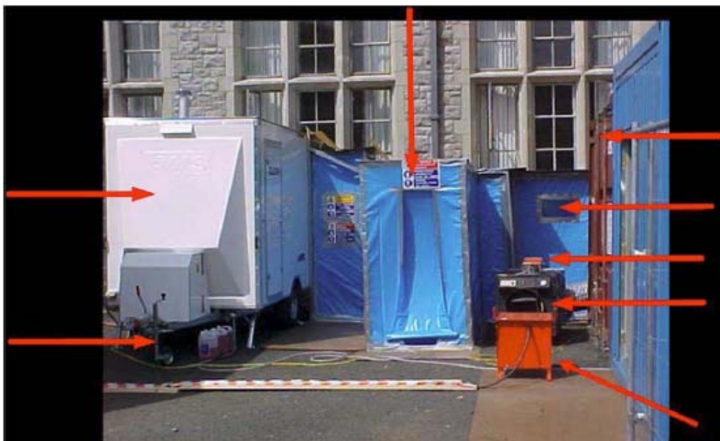
Figura 12.1. Intrarea într-o incintă. Săgețile, începând cu cea de sus, în sensul acelor de ceasornic, indică următoarele elemente: sas, container de deșeuri, panou de vizualizare, manometru de presiune, grupul de depresiurizare, alimentarea electrică, stocare agent de umectare și grupul de decontaminare.
