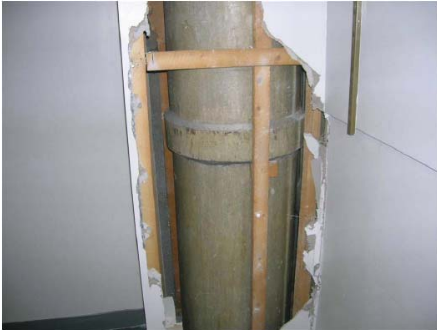
Figura 4.2 Cofraj din panou izolant de azbest, demontat parțial pentru a arăta țeava de gaze arse din azbociment.
