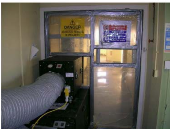
Figura 12.2. Grupuri de depresiurizare și conducte de evacuarea aerului, panouri de vizualizare și panouri de avertizare.
