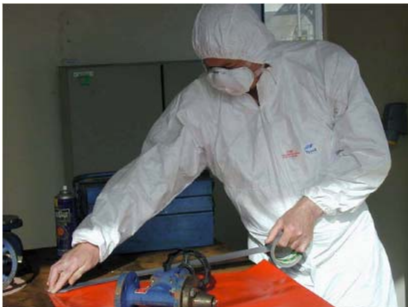
Figura 11.3. Utilizarea de benzi și foi de polietilenă pentru protejarea zonei de lucru înainte de curățarea garniturilor din azbest ale unei vane.
