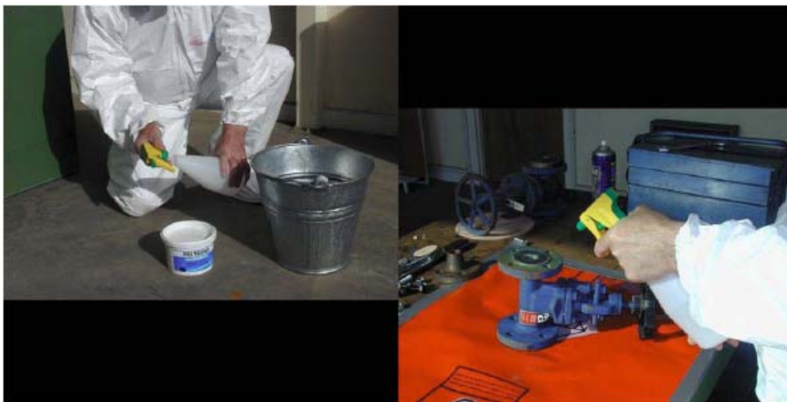
Figura 11.4. Udarea joantei din azbest a unei vane.
