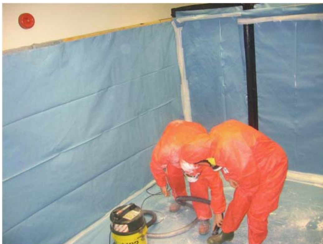
Figura 7.1 Instruirea practică pentru utilizarea aspiratoarelor tip H pentru îndepărtarea unei contaminări simulate (pudra de talc). Fotografie pusă la dispoziție de organismul britanic HSE.
