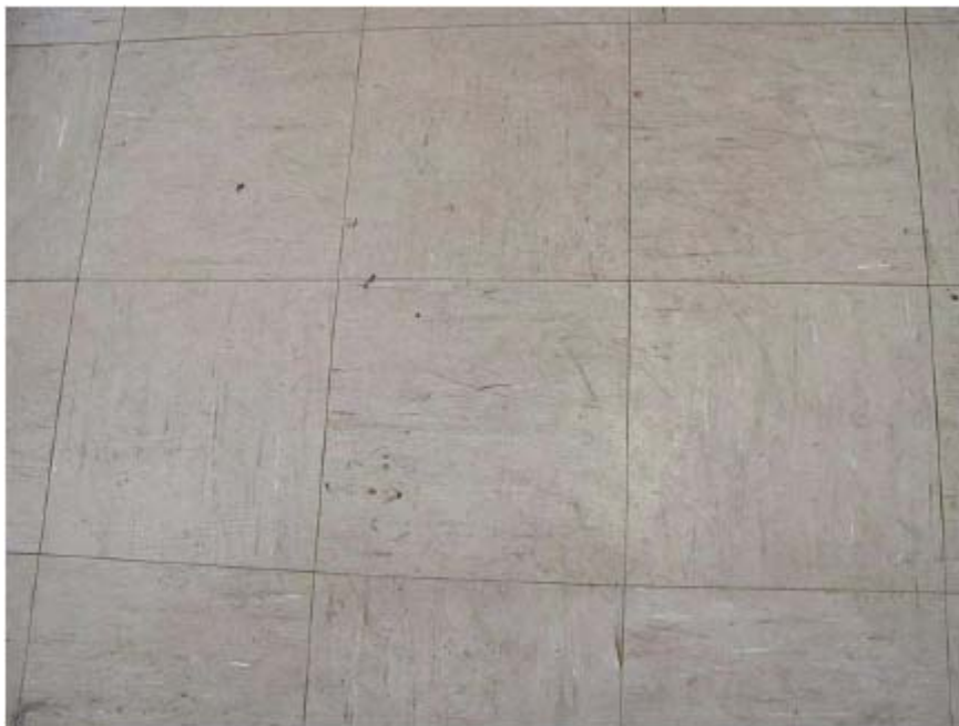
Figura 4.6 Dale de sol din azbest
