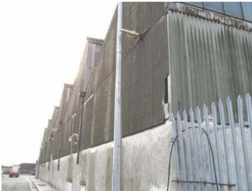
Figura 4.10 Ornament din placi ondulate de azbociment într-o uzină.
