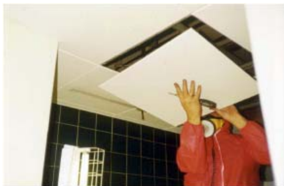
Figura 12.13. Depunerea cu precauție a unei plăci din azbest. Fotografie pusă la dispoziție de organismul britanic HSE.
