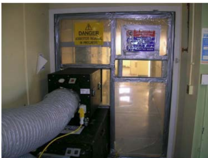
Figura 12.1. Intrarea într-o incintă. Săgețile, începând cu cea de sus, în sensul acelor de ceasornic, indică următoarele elemente: sas, container de deșeuri, panou de vizualizare, manometru de presiune, grupul de depresiurizare, alimentarea electrică, stocare agent de umectare și grupul de decontaminare.
