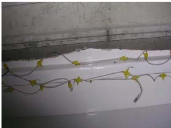
Figura 12.10. Exemplu de injecție multipunct utilizată pentru umectarea flocajului izolator din azbest.
