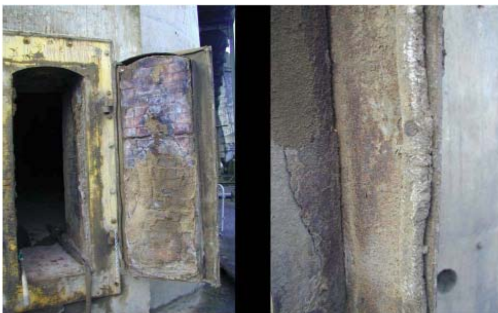
Figura 4.12 Etanșeitate prin șnur din azbest pe o trapă de șemineu. Imaginea din dreapta este o vedere apropiată a șnururilor împletite.
