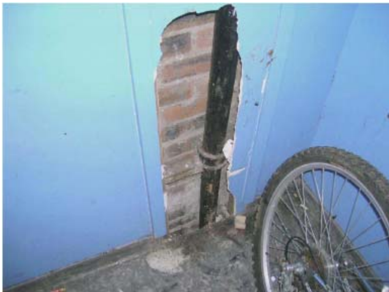
Figura 6.4 Panou izolanț din azbest; depunerea trebuie prevăzută deoarece panoul riscă să fie deteriorat în acest amplasament.
