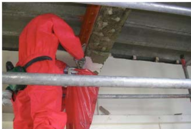
Figura 12.11. Deșeuri puse în sac aproape de punctul de depozitare pentru a evita dispersia și pentru a reduce expunerea.
