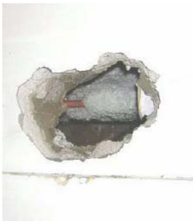
Figura 4.4. Orificiu într-un perete care arată izolarea unui tub din azbest.
