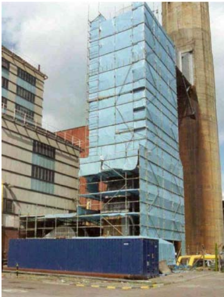
Figura 12.3. Incintă creată pentru izolarea termică a unei conducte de gaz ars
