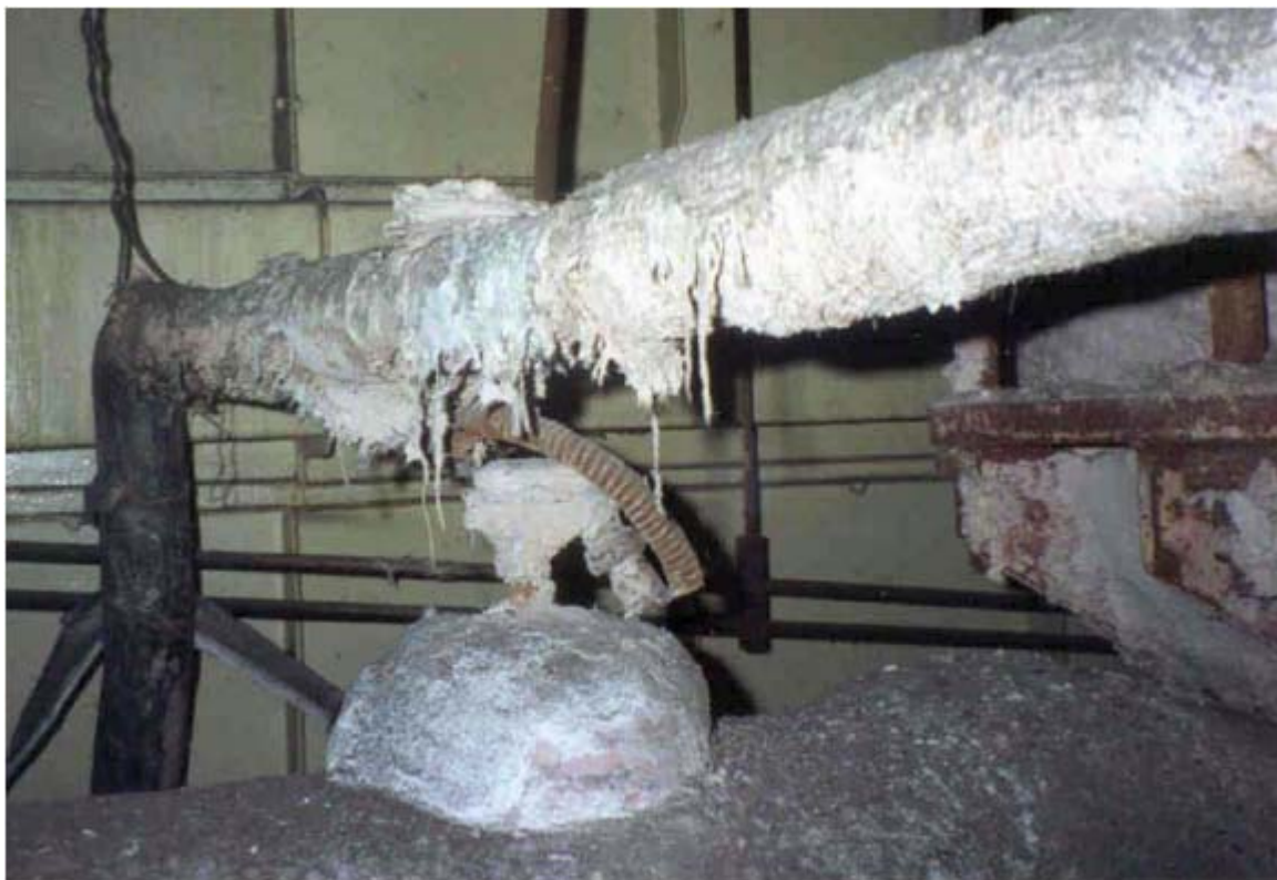
Figura 4.8 Izolant din azbest pe conductele de vapor.
