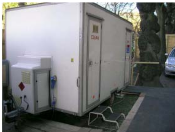
Figura 12.6. Unitatea de decontaminare mobilă.
