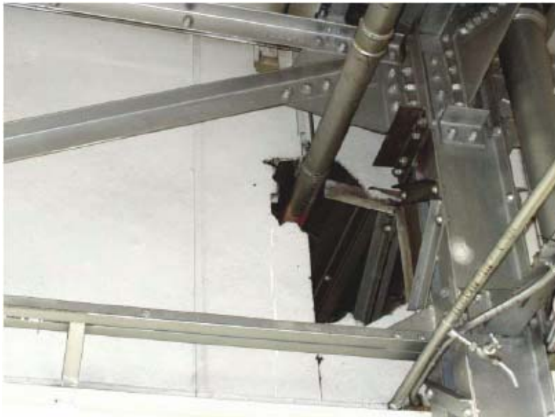
Figura 4.3 Perete interior din panouri izolante de azbest. Acest exemplu ilustrează dificultățile practice pentru construirea unei incinte corespunzătoare și arată deasemenea, suprafețele unde se poate depune praf de azbest în timpul operațiunii de demolare.
