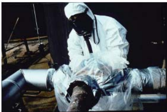
Figura 12.12. Saci cu mănuși pentru depunerea controlată a izolațiilor termice din azbest (fotografii furnizate de INRS; drepturi de reproducere INRS)
